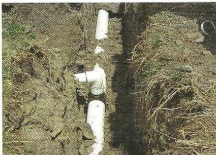
Conexión de la línea primaria y secundaria para los sistemas de riego por aspersión y microaspersión con reducción de 4 a 3 y salida a 2 pulgadas.
