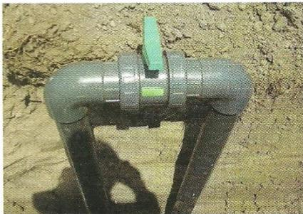
Instalación de válvula de ubicación de cierre y apertura, conectada a las líneas primaria y secundaria.
