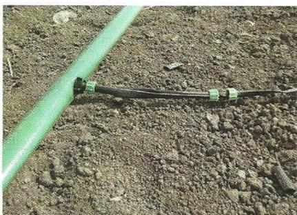
Instalación de la línea primaria para el establecimiento del sistema de riego por goteo, a base de una manguera de lona de alta resistencia de 4 pulgadas
